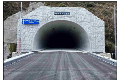
新阪本トンネル
