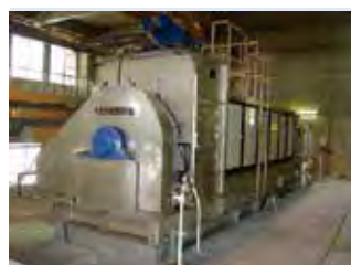
汚泥脱水機更新工事 (老朽化した機器の更新)
