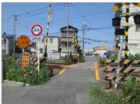
▲南大安寺踏切道
