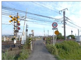
▲中八条踏切道
