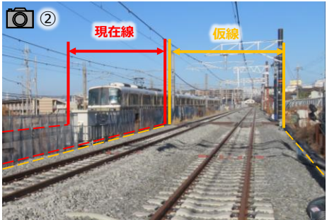
▲南大安寺踏切付近(仮線工事)
