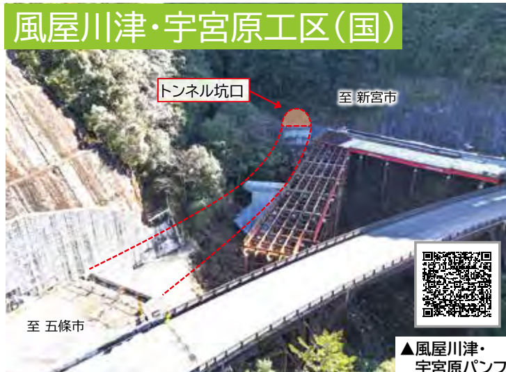
十津川村川津 橋梁下部工事
