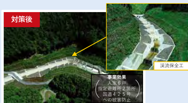
▲渓流保全工を施工し、土砂流出再発を防止。 (写真:吉野郡十津川村 大畑瀬 2023年)
