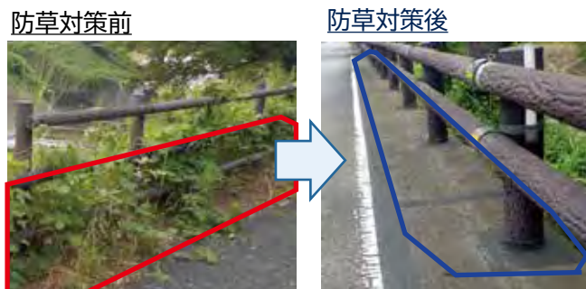
▲雑草が生える隙間を無くすことで雑草のはみ出しを軽減させる
