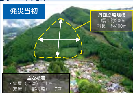
▲台風11号により、大規模な地すべりが発生。 (写真:吉野郡天川村 坪内 2015年)
