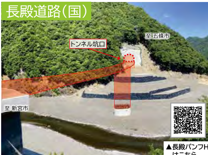
十津川村長殿 橋梁下部工事
