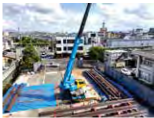
▲【工事中】地下貯留施設(大和高田市)
