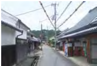
▲歴史ある街並みを電柱・電線が阻害 あまかしのおが (県道から甘樫丘を望む)
