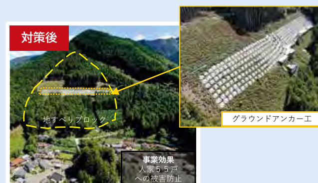
▲グラウンドアンカー工を施工し、地すべり再発を防止。 (写真:吉野郡天川村 坪内 2023年)
