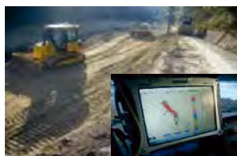
▲ICT建設機械による施工
