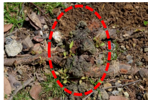
露出根に発生したがんしゅとみられる部位
