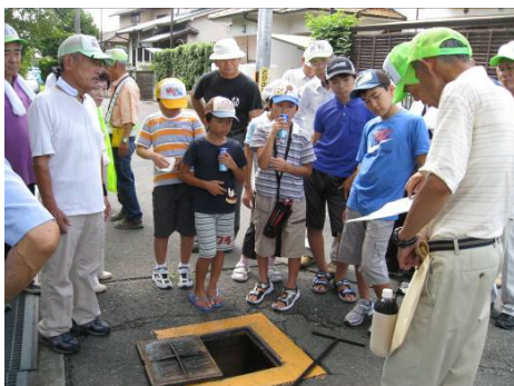
消火栓の蓋をあけると・・・。
