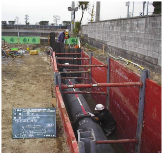
用水管の改修状況
