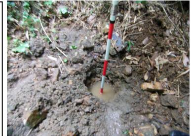
(堰堤下部漏水状況)
