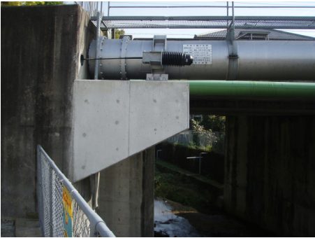
（水管橋脱落防止対策）
