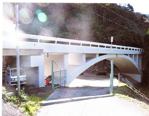
国道168号 桑畑小井橋 吉野郡十津川村村桑畑地内
