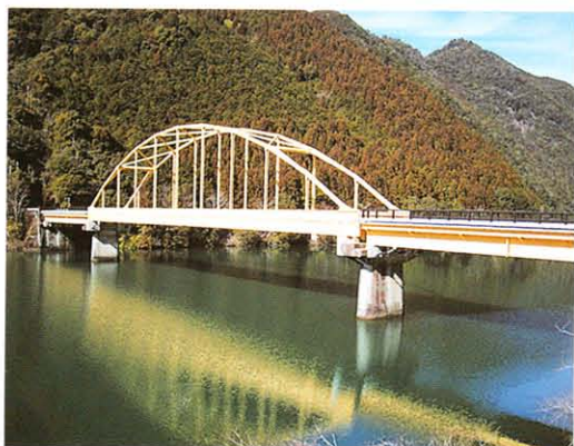
国道169号 小口橋 吉野郡下北山村下桑原地内
