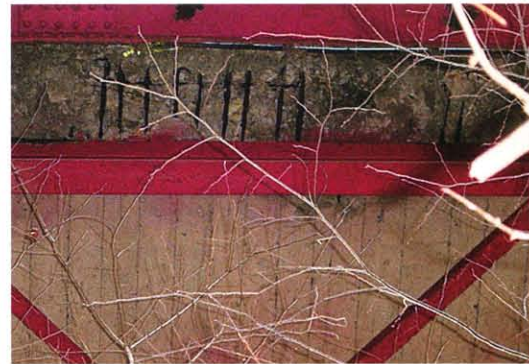
床版の鉄筋露出
