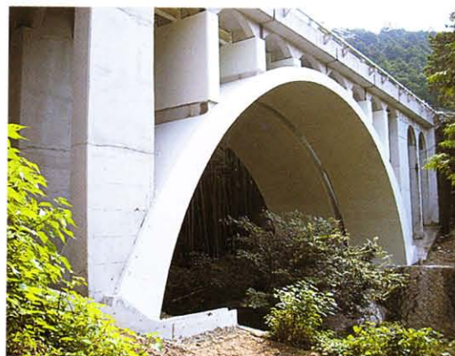
国道168号 高橋 吉野郡吉野町河原屋地内
