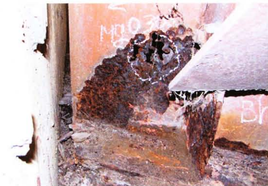
鋼桁の腐食
