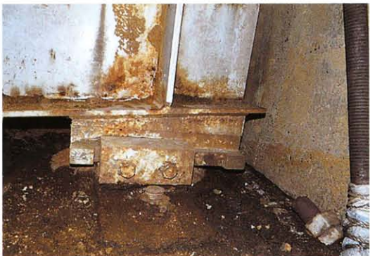
支承の機能障害
