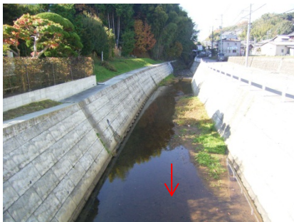
改修中の区間（生駒市鹿畑町）
