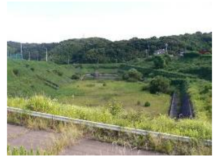
高山防災調節池（生駒市高山町）
