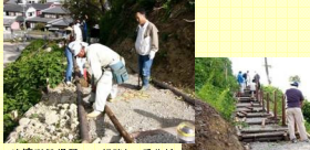
津波避難場所への経路に、手作りの手すりを取り付け
