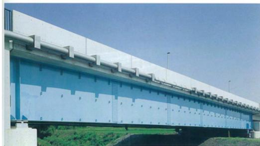
○耐候性鋼材を利用し、塗装しない事例
