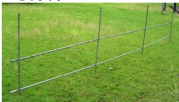
写真5 鉄パイプ設置完了
