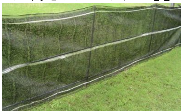
写真7 目隠しネット設置後
