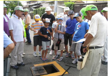
消火栓の蓋をあけると・・・
