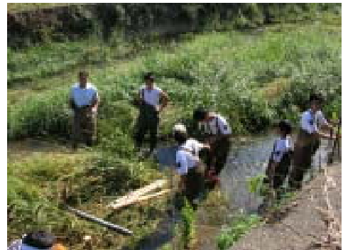
ホタルが棲める川を目指して、河床に木杭を打ち込む作業。生徒、教員、保護者や地域の人たちの協力で行っている。
