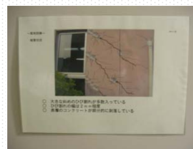
被害状況写真
