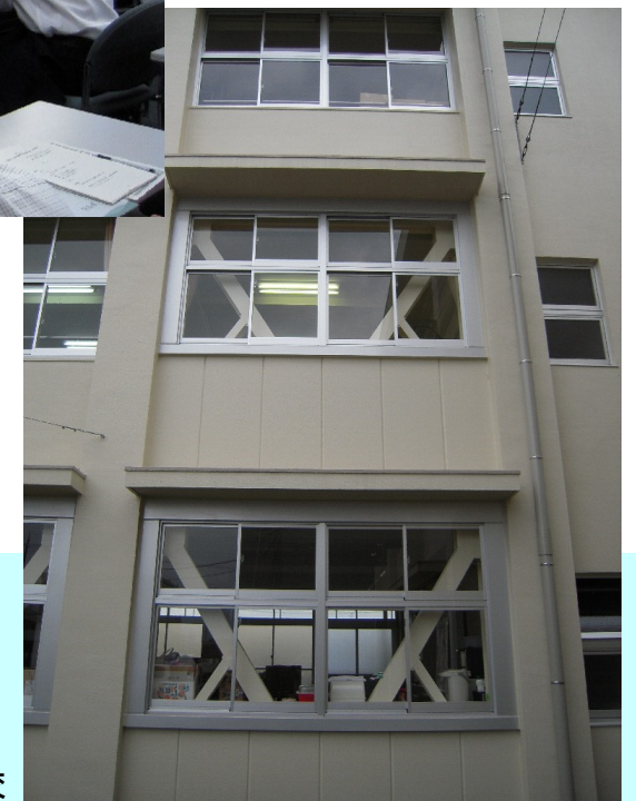
《耐震改修事例》 大和郡山市立郡山西中学校
