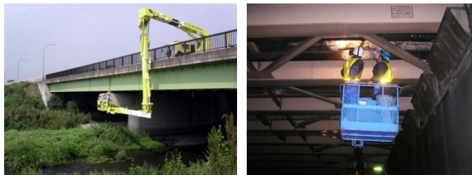
橋梁点検車を使った橋梁点検
