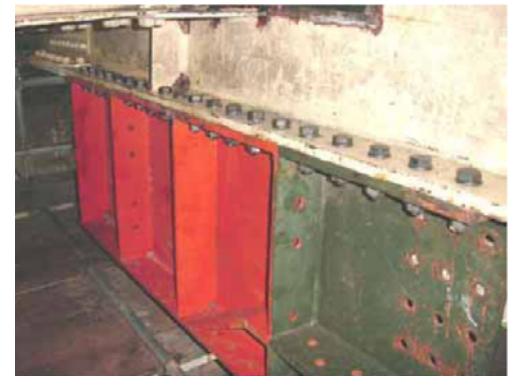
主桁下フランジ H鋼補強
