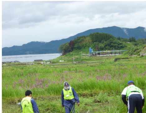
瓦礫の撤去作業
