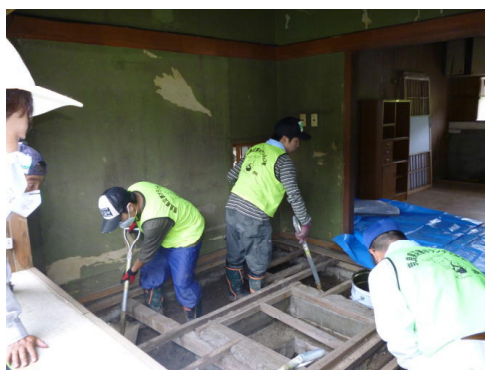
家屋内の泥の撤去作業
