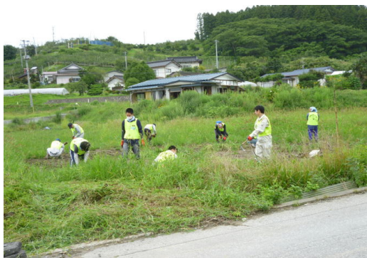
瓦礫の撤去作業
