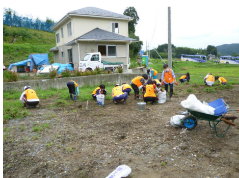
瓦礫の撤去作業
