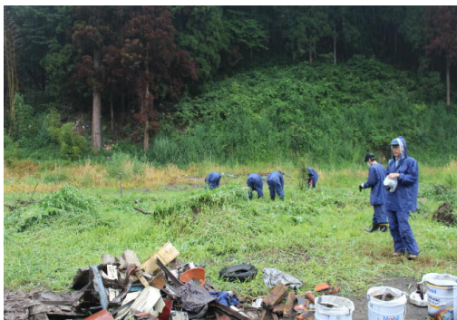
瓦礫の撤去作業
