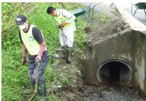
水路の泥上げ
