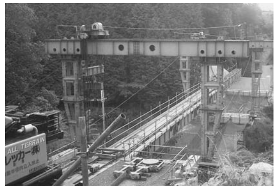
ガーダー架設完了
