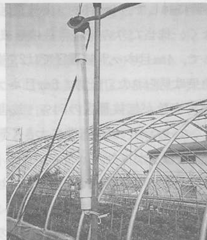
第1図 黄色蛍光灯設置状況
