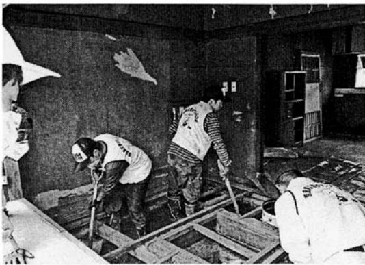
津波で流れ込んだ土砂をかき出す生徒=23日、岩手県陸前高田市 (県教委提供)
