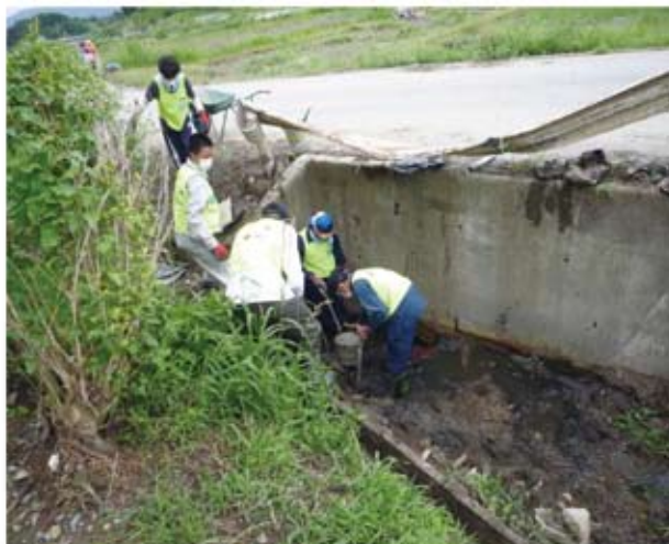
水路の泥上げ
