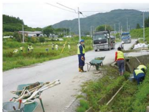
水路の泥上げ
