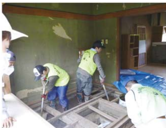
家屋内の泥の撤去
