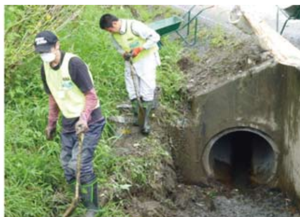
水路の泥上げ
