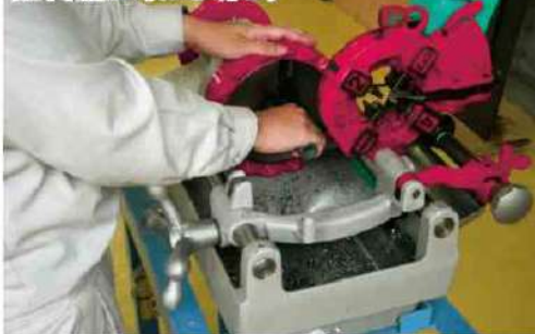
配管加工(ねじ切り)
