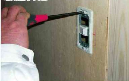
電気工事实習
