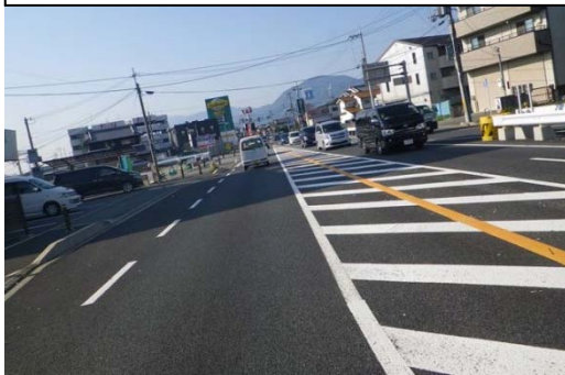
写真①: 志都美駅付近
