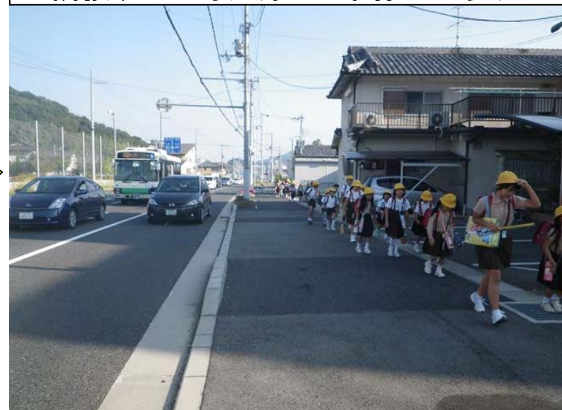
隣接する王寺道路の4車線化の状況
