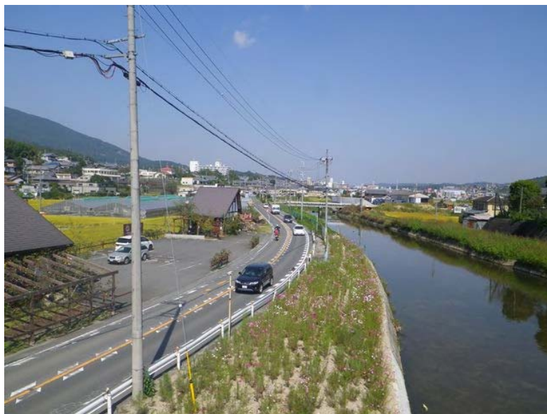
バイパス(1工区)整備区間
