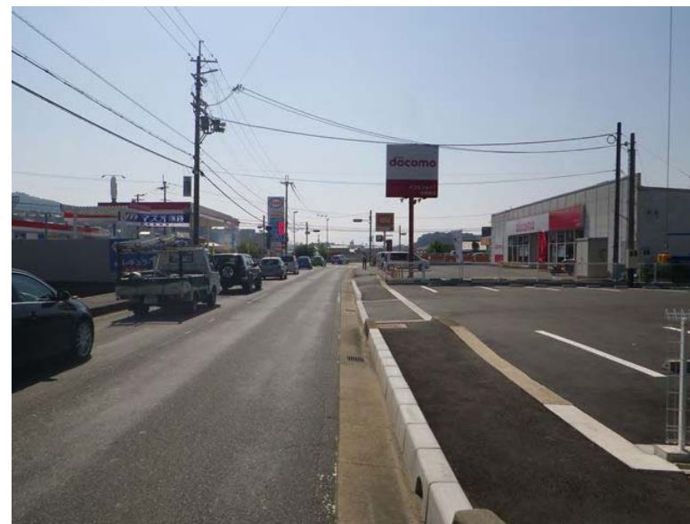
現道拡幅(2工区)区間
