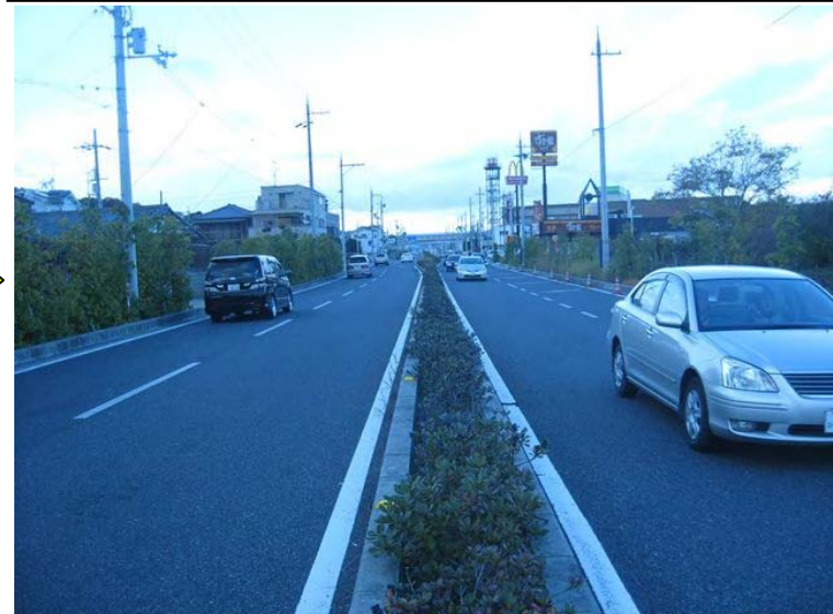
隣接する一分バイパスの4車区間の状況
