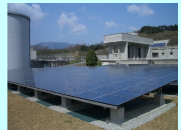
御所浄水場の太陽光発電
