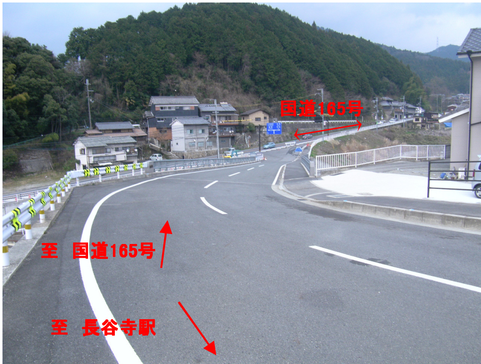
長谷寺駅方面から国道165号向きを撮影
