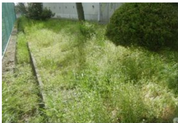
体育館北側の側溝と草の状況
