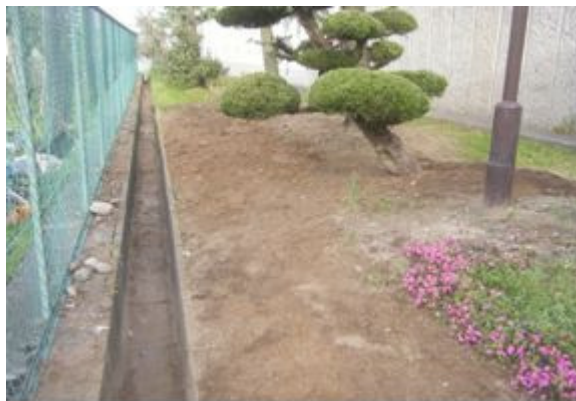
草刈りと側溝の土を堀上
