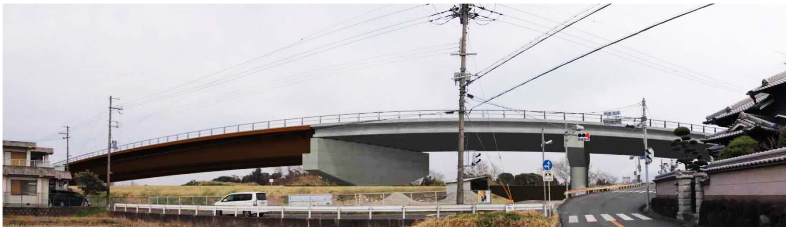
(仮称)新宮前橋
