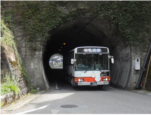
② 幅員が狭く、すれ違いが困難なトンネル
