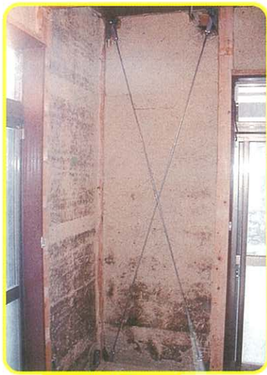
鋼製筋違取付
