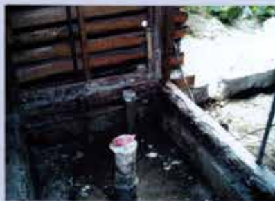
土台が腐朽している
