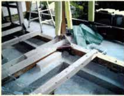
新しく基礎を設ける
