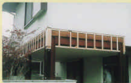
鉄骨フレームを設け、オーバーハングした2階部分を支える柱を補強しました。
