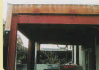
鉄骨フレームと既設の梁や柱をボルトでしっかりと緊結しました。鉄骨は変形に対して粘り強い性質があることから、既存部分と緊結することにより、地震力に対する効果が期待できます。
