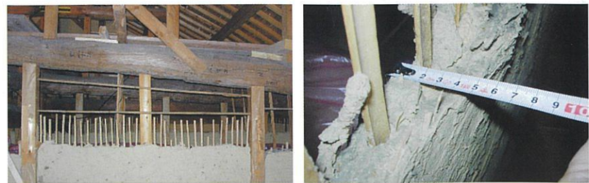
（土塗壁が梁下まで届いていない：強度が低減）（壁厚が薄い：5cm以上ないと十分な強度は期待できません）
