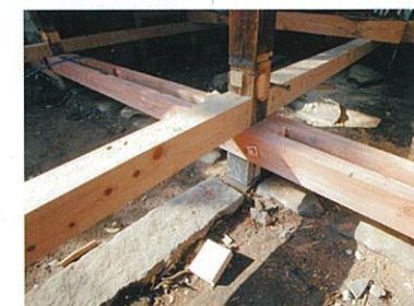
《 柱脚部の補強 》
