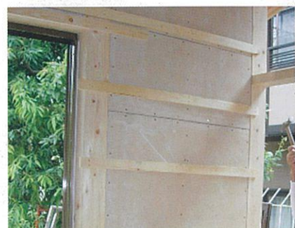
既製土壁パネルの設置
