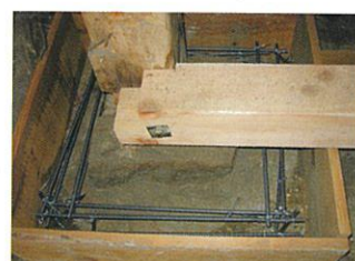
玉石基礎の補強 (コンクリート打設前)
