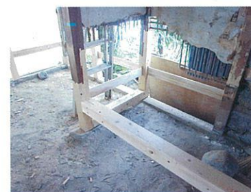
《 柱脚部の補強 》
