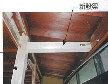
新設柱・新設梁を取付けて、耐震性を高めます。
