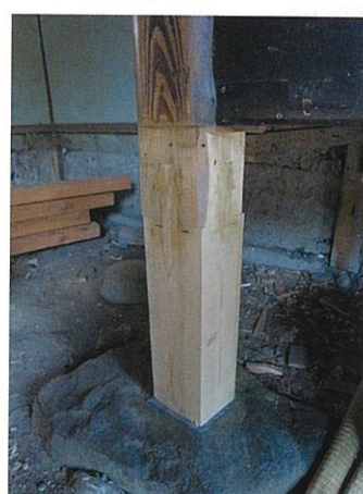
柱脚部の補強
