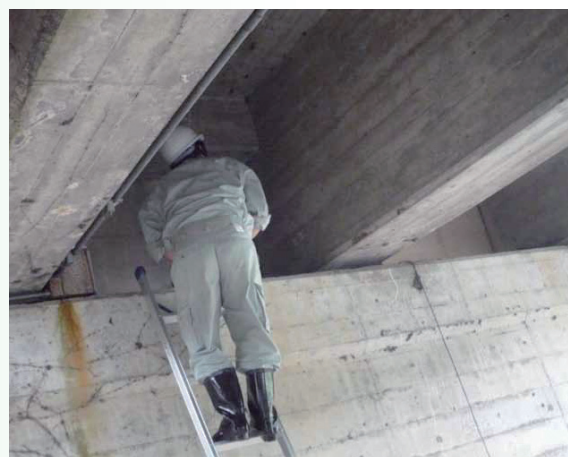
橋梁の定期点検状況
