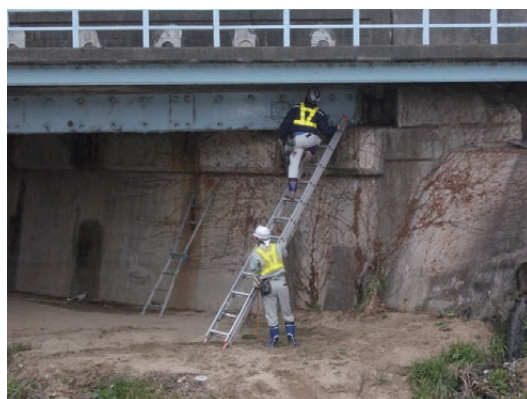
道路構造物の点検状況
