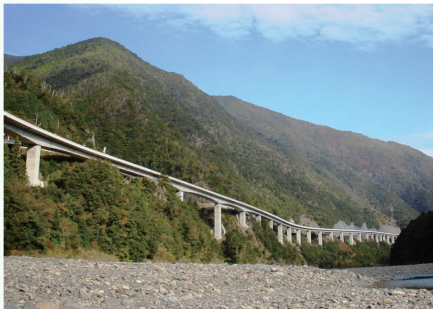
十津川溪谷の自然環境と景観の保全に配慮した整備事例(七色高架橋)
