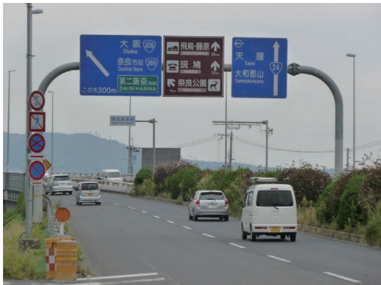
観光地案内と道路案内標識を組み合わせた事例
