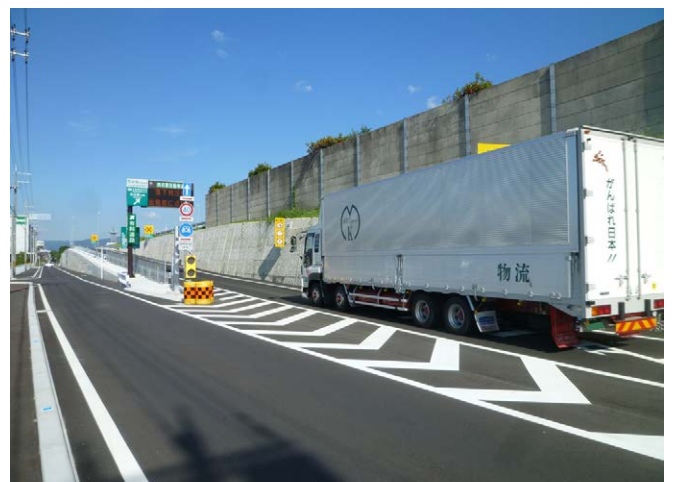
西名阪自動車道と大和中央道を結ぶ大和まほろばスマートIC (近畿初のスマートIC)
