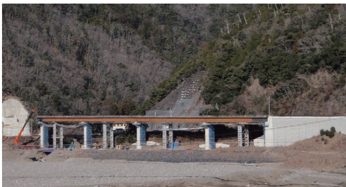
⑩ 国道168号:川津道路(十津川村) (平成21年度 一部開通)
