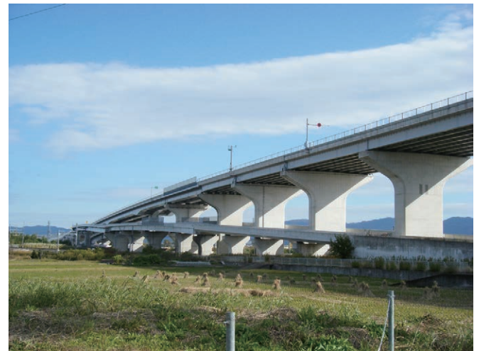
工事が進む京奈和自動車道(田原本町)
