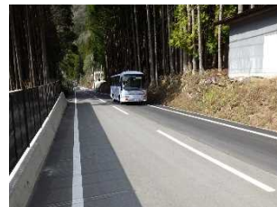
主要地方道高野天川線 塩谷～九尾工区 (吉野郡天川村和田) [R4年3月 一部開通]
