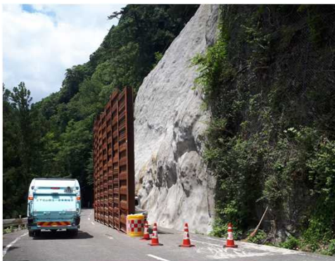
(道路防災対策)
