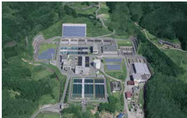
奈良県水道局御所浄水場
