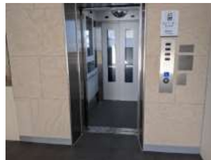
エレベーターの設置
