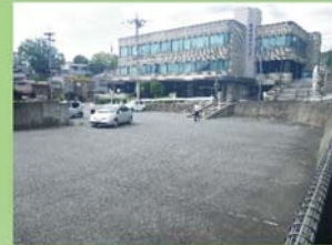
榛原総合センター駐車場
