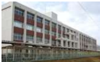
耐震化の完了した校舎
