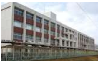
耐震化の完了した校舎
