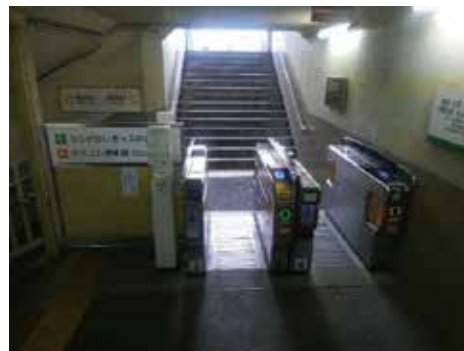
ホームまでの経路の段差が未解消の駅の例
