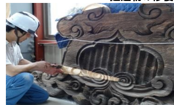
建造物の修復
