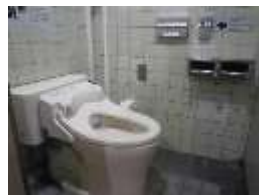
洋式トイレに更新した 大仏殿前駐車場トイレ
