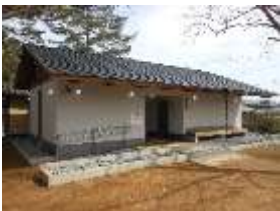
建替後の 五十二段北トイレ
