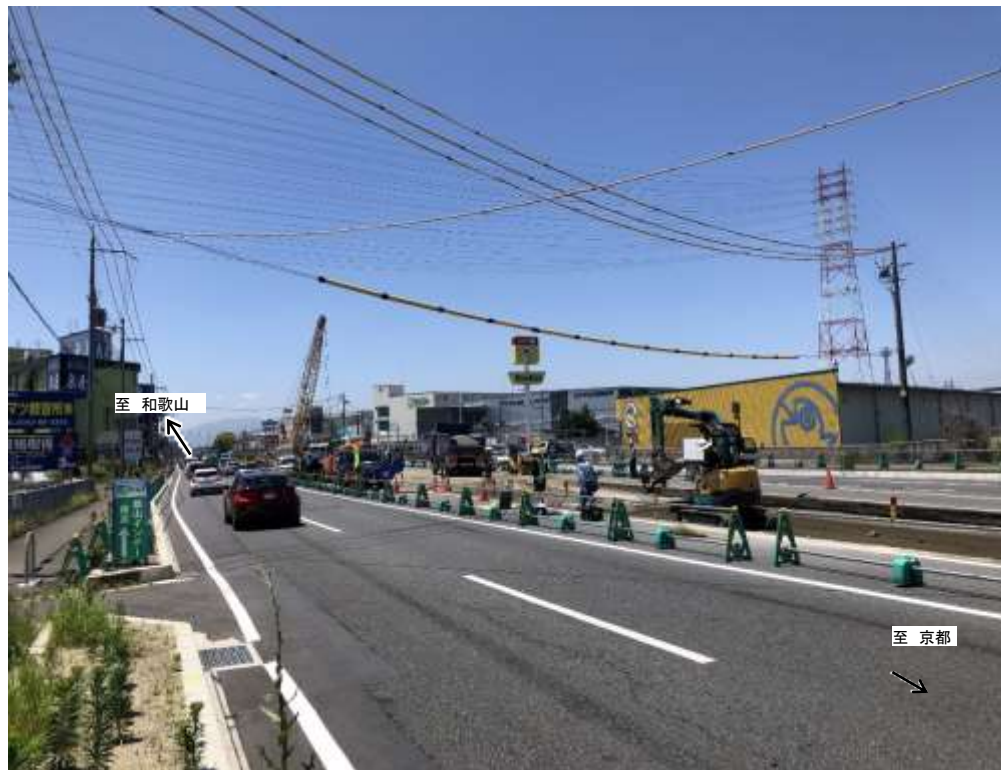
大和北道路(大和郡山市横田町)
