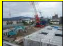
工事中の地下貯留施設(田原本町)
