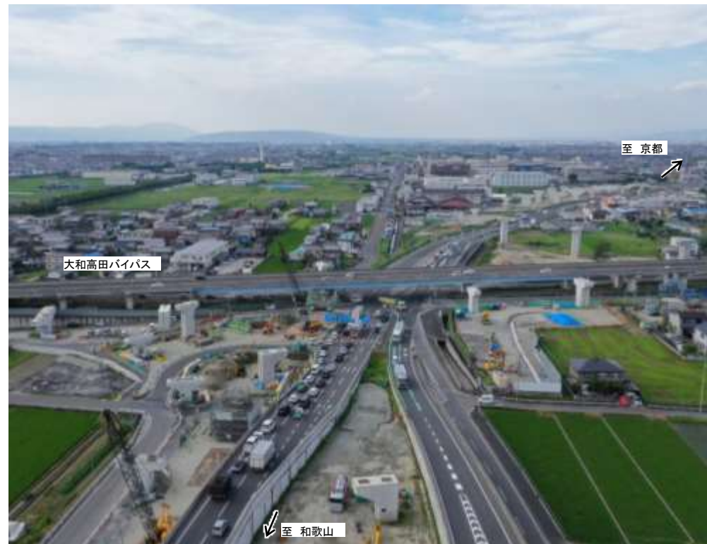
大和御所道路(橿原高田IC付近)
