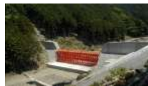
砂防設備の設置
