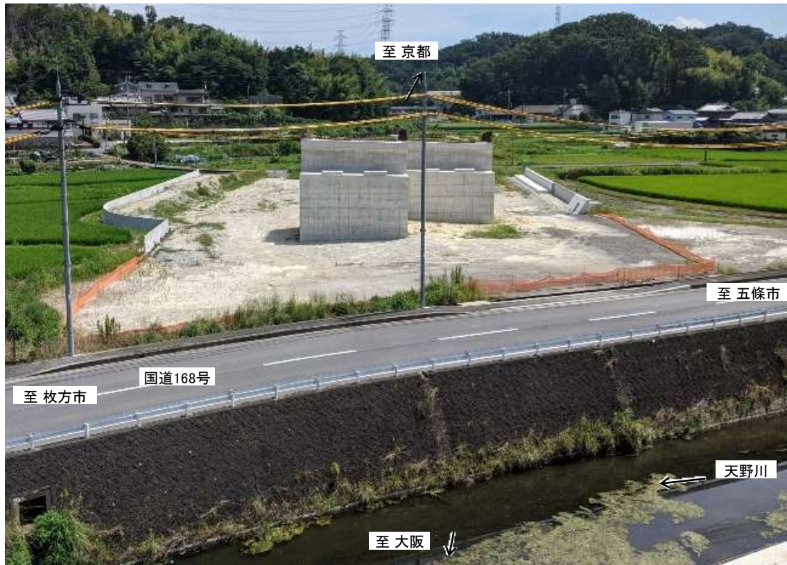
①(仮称)下田原東ランプ(橋梁下部工事)
