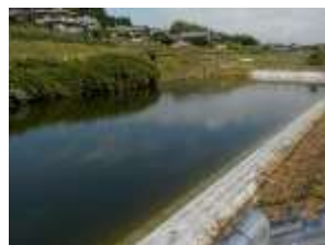
農業用ため池の整備
