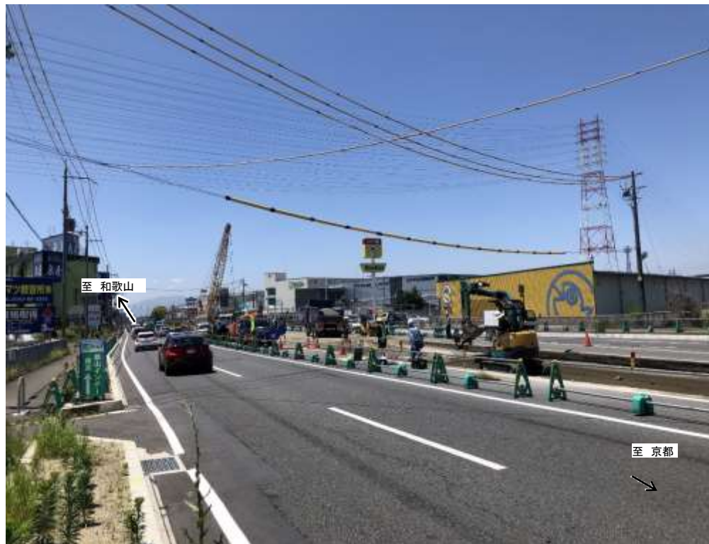
大和北道路(大和郡山市横田町)
