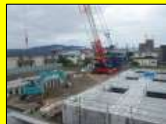
工事中の地下貯留施設(田原本町)
