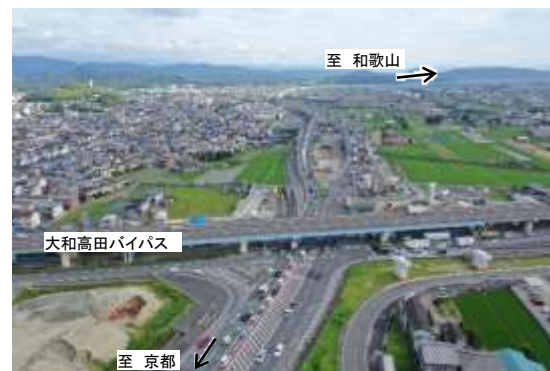
② 橿原市新堂町ランプ部 (橋梁下部工事)
