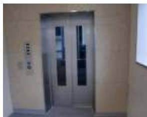
近鉄坊城駅(橿原市)に新たに設置されたエレベータ
