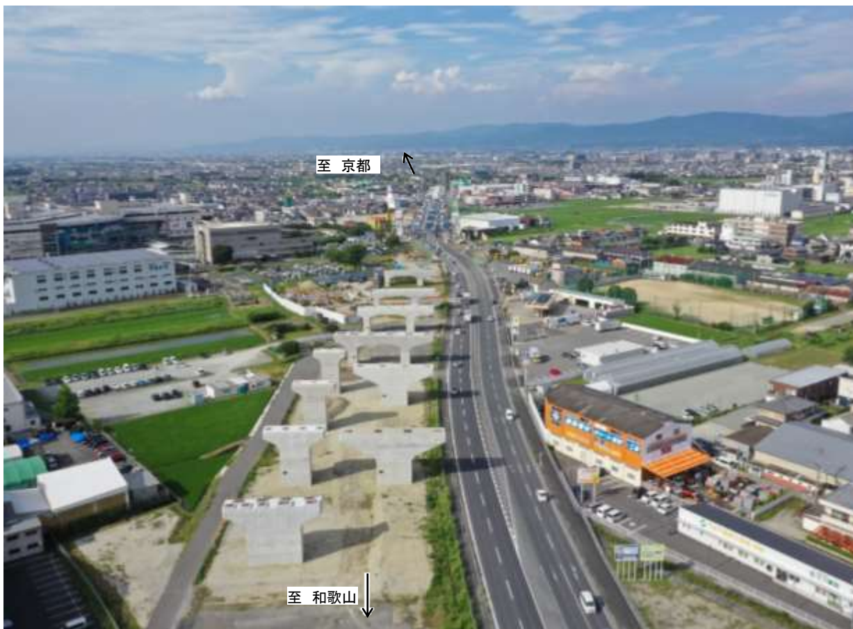
③ 橿原市曲川町本線部 (橋梁下部工事)
