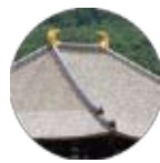
東大寺大仏殿の屋根
