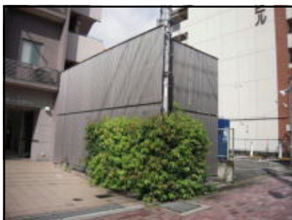
【受水槽をルーバーと植栽で隠した事例】
