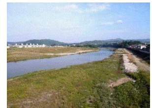
国道168号・大川橋
